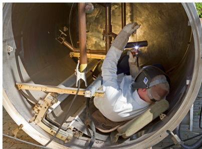
Metallfachkräfte beim Schweißen im Behälter und unter Baustellenbedingungen
