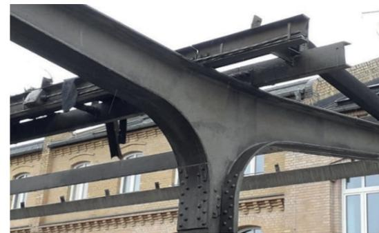
Abbildung 1.1: genietetete Stützen aus historischem Flussstahl
