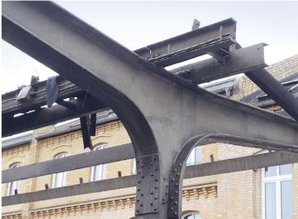
Abbildung 1: genietete Stützen aus historischem Flusstahl.
