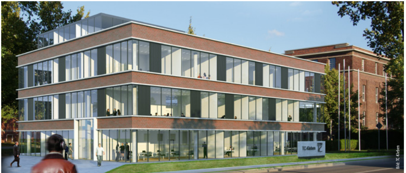
Der geplante Neubau des TC-Kleben verbindet moderne Architektur mit denkmalgeschützter Bausubstanz.
