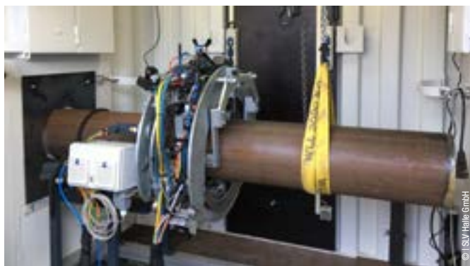
Schweißposition im Schweißcontainer
