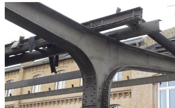
Abbildung 1.1: genietete Stützen aus historischem Flussstahl
